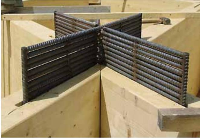
La copertura della chiesa di San Rocco a Gela (CL) costituisce un ottimo esempio di vero graticcio in legno lamellare con giunti rigidi a quattro vie.
